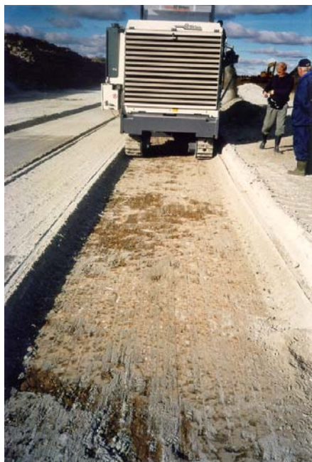
Pilt 3.1. Firma Wirtgen freeskombaini katsetamine Põhja-Kiviõli karjääris. Vasakul – näide, et kombaini töösügavus on täpselt reguleeritav; üleval - kaevisse laadimine kallurile.
